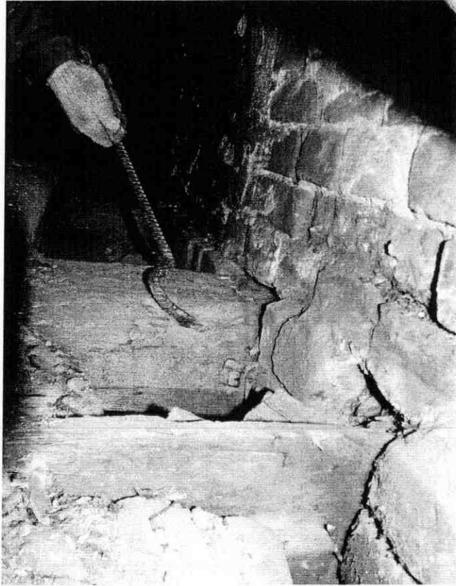
zmurszała końcówka belki stropowej nad II piętrem
