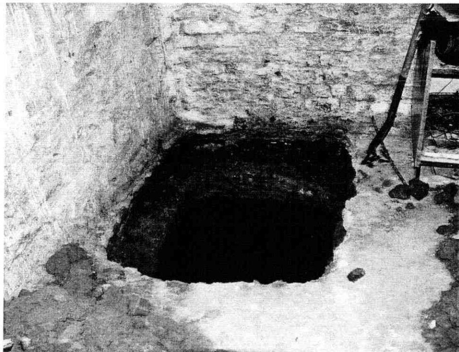
odkrywka nr 2 - piwnica
