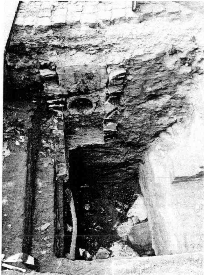
odkrywka nr 1 na zewnątrz budynku
