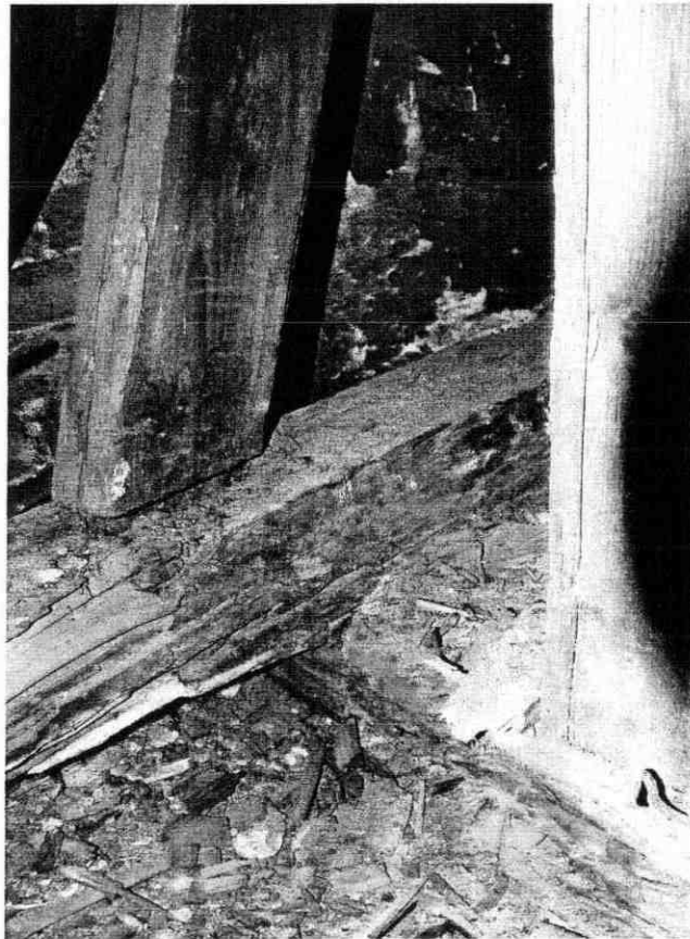
zmurszała końcówka belki stropowej nad II piętrem
