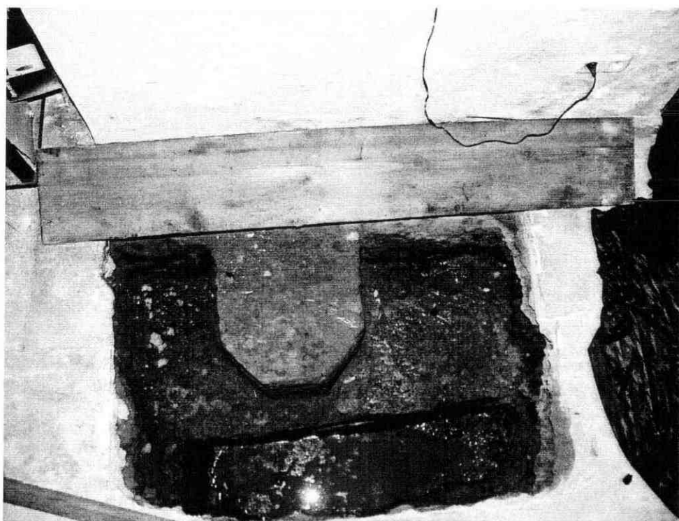
odkrywka nr 4 - piwnica, „grota”
