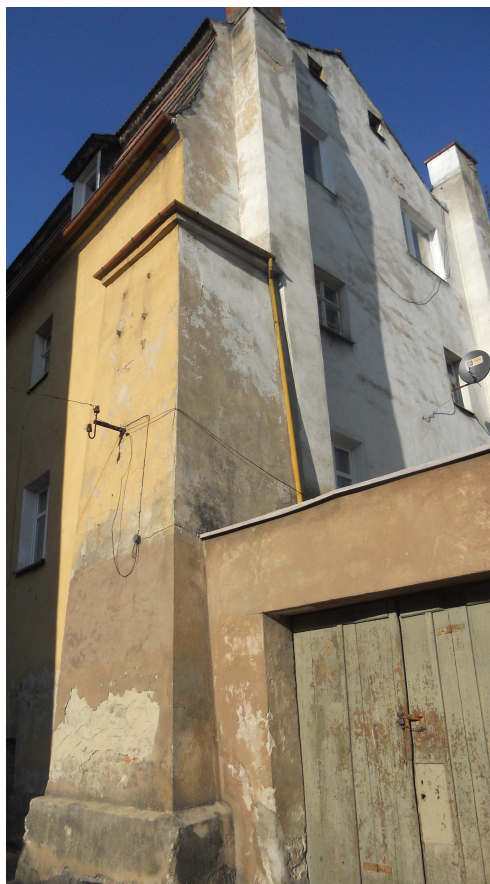
Fot. 2 Elewacja tylna
