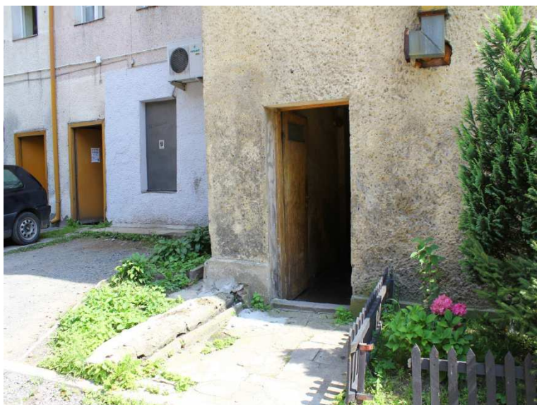
Zdjęcie nr 3 Dojścia do kamienic od strony działki 37/10. (na dojściach widoczne są progi do 3cm)
