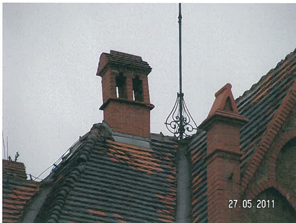
Szczegół komina oraz metalowej iglicy.
