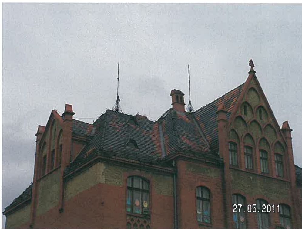
Widok na dach.
