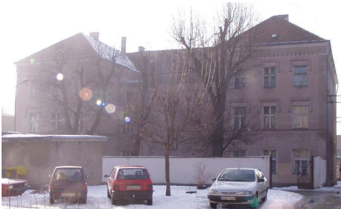
Widok budynku głównego od strony wschodniej,
