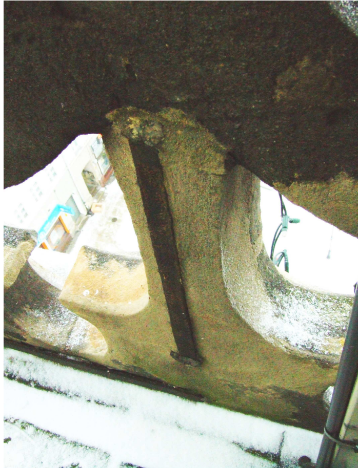
fot. 9 balustrada, widoczne stalowe klamry
