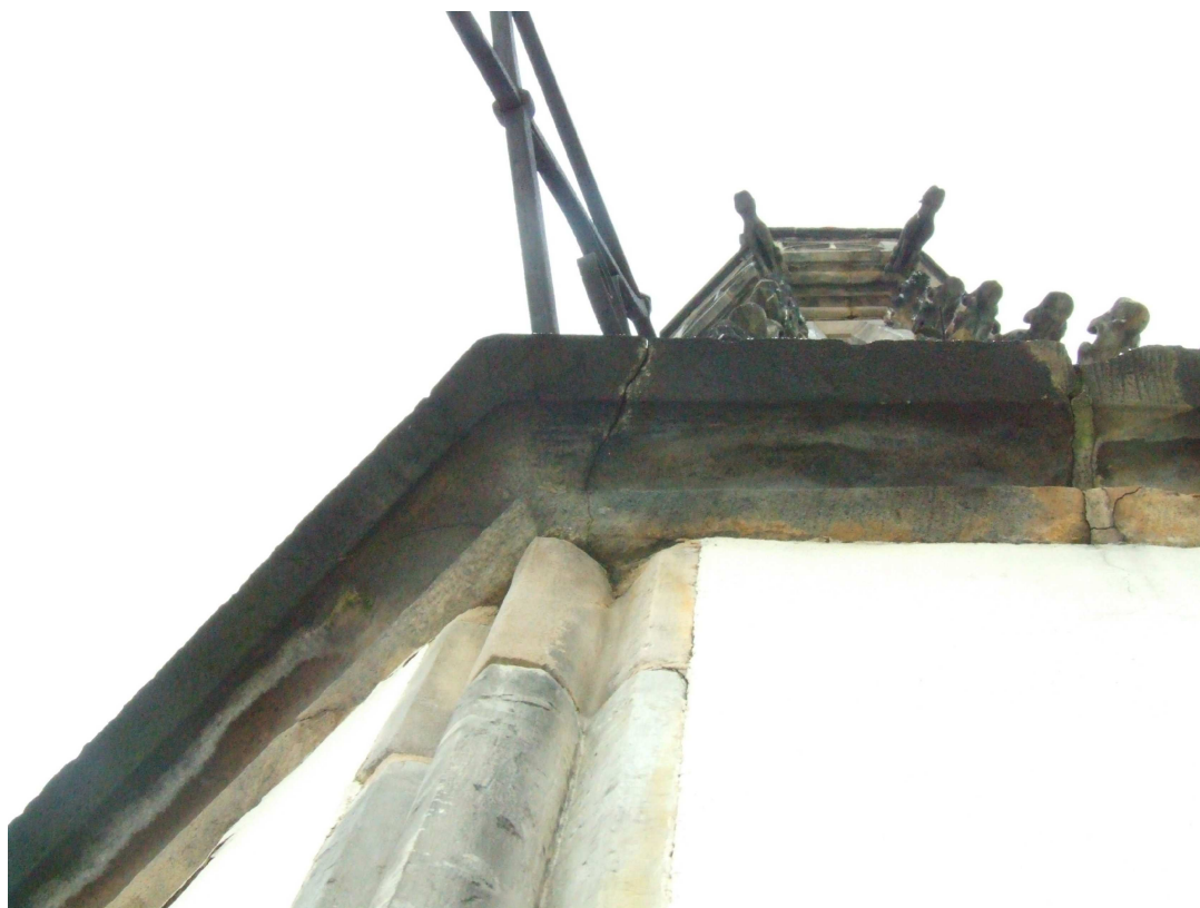
fot. 5 narożnik wieży – gzyms okapowy
