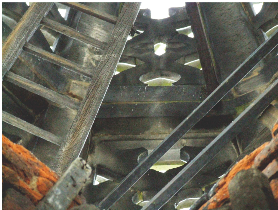
fot.1 ażurowy hełm wieży, widok od środka
