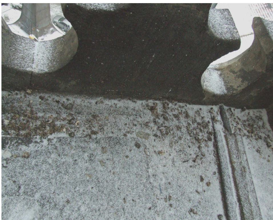
fot. 8 balustrada, posadzka galerii
