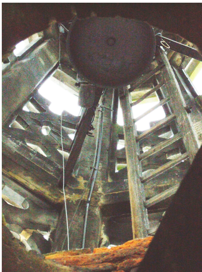
fot. 4 ażurowy hełm wieży, widok od środka
