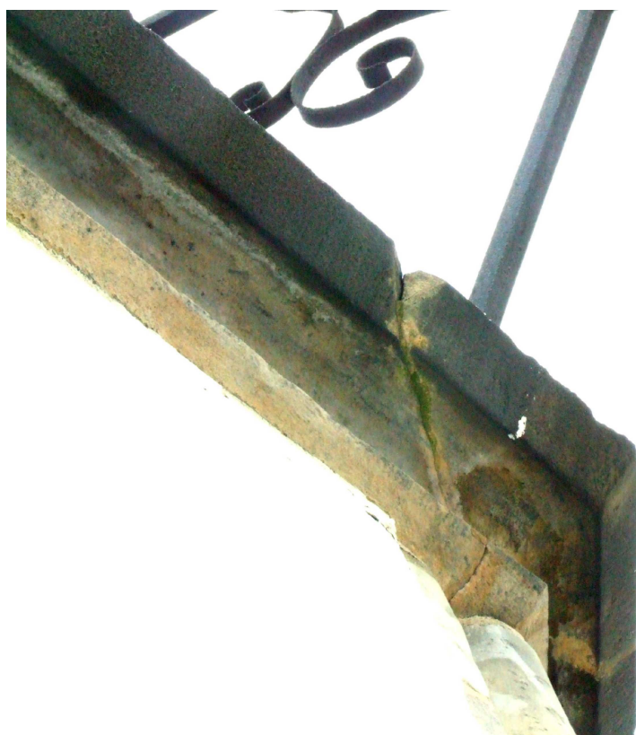
fot. 6 narożnik wieży – gzyms okapowy
