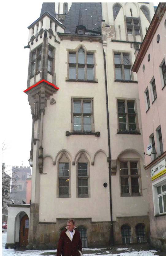
fot. 24 elewacja frontowa, miejsca proj. obróbek blacharskich
