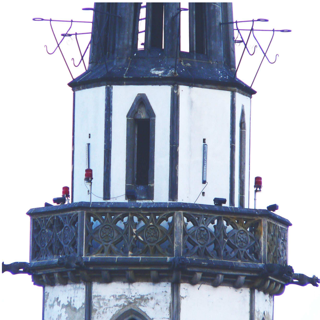
fot. 23 wieża, poziom 3
