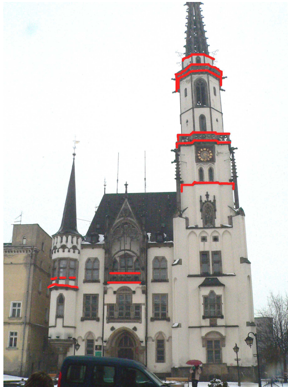
fot. 24 elewacja frontowa, miejsca proj. obróbek blacharskich
