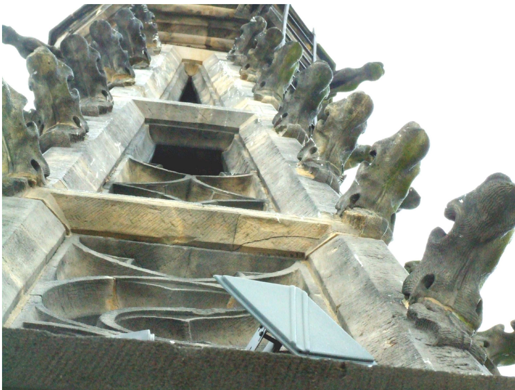
fot.3 ażurowy hełm wieży, widok od zewnątrz
