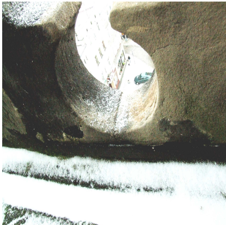
fot.10 balustrada, widoczne zagłębienie w posadzce galerii odprowadzające wodę do rzygaczy
