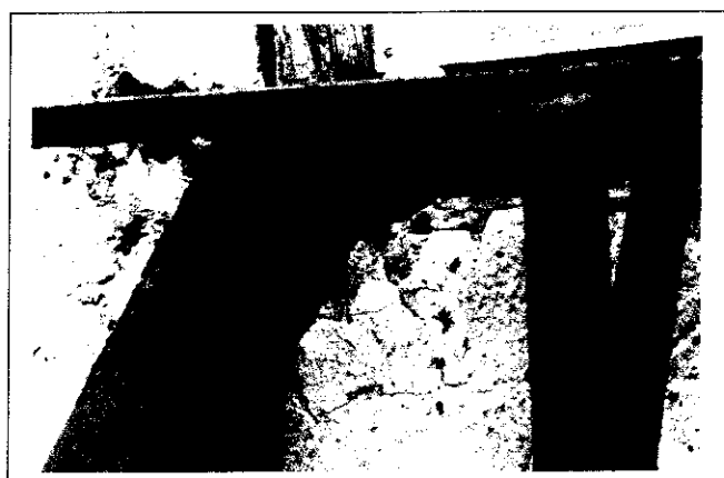
Fot 9 i 10 Widok skorodowanych miejsc oparcia schodów na ścianie sceny
