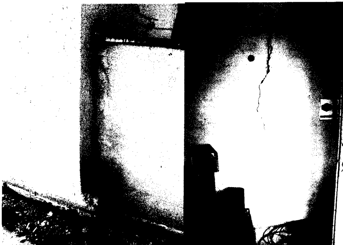
Fot. 22 Widok pęknięcia muru na dachu pomiędzy oraz przez strop na ostatniej kondygnacji zaplecza sceny (4).
